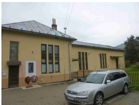
Obr.č.3 Pohľad južný
