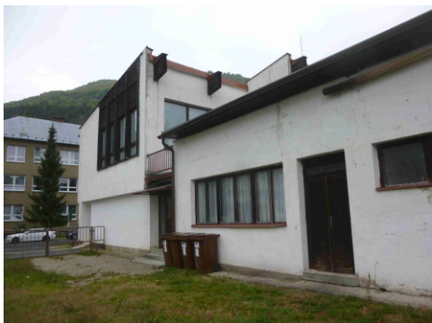
Obr.č.3 Pohľad južný
