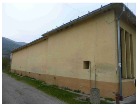
Obr.č.4 Pohľad severný
