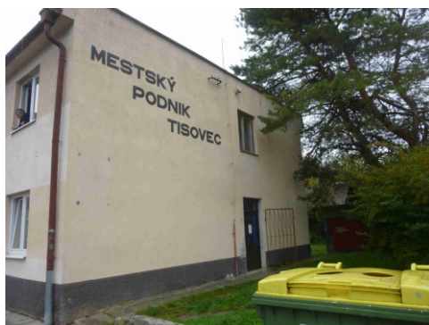
Obr.č.3 Pohľad južný
