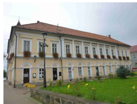
Obr.č.4 Pohľad severný
