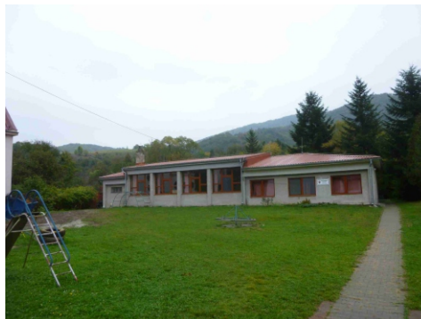
Obr.č.2 Pohľad západný
