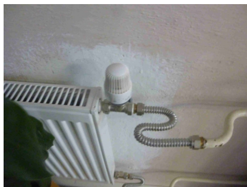
Obr.č.11 Prvky systému vykurovania
