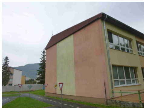
Obr.č.2 Pohľad západný
