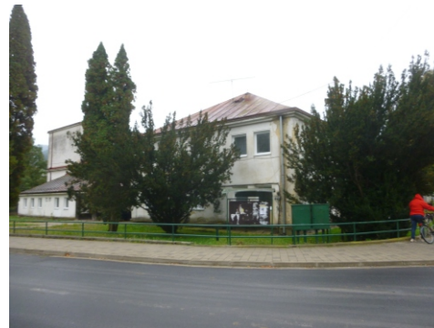
Obr.č.4 Pohľad severný
