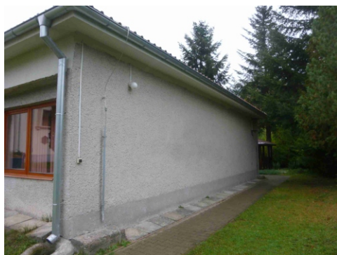
Obr.č.3 Pohľad južný
