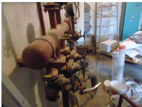
Obr.č.9 Prvky systému vykurovania
