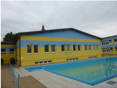
Obr.č.3 Pohľad južný
