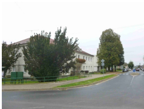
Obr.č.2 Pohľad západný
