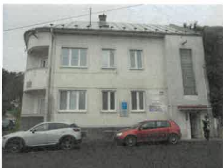
Obr.č.1 Pohľad východný
