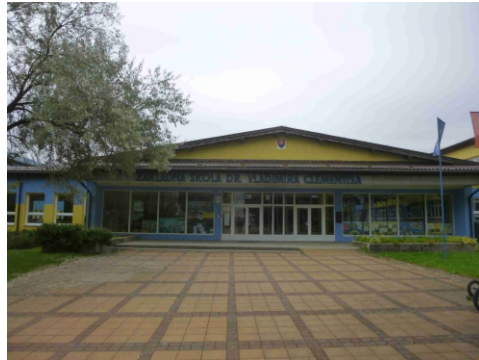
Obr.č.4 Pohľad severný
