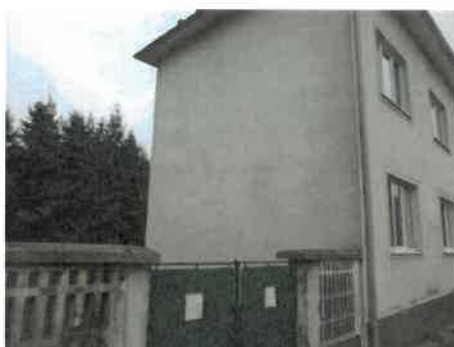
Obr.č.2 Pohľad západný
