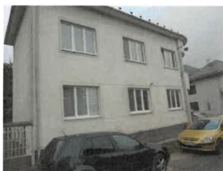
Obr.č.3 Pohľad južný
