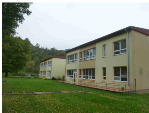
Obr.č.3 Pohľad južný
