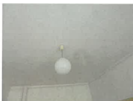
Obr.č.16 Prvky systému umelého osvetlenia
