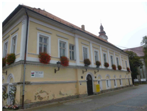
Obr.č.2 Pohľad západný
