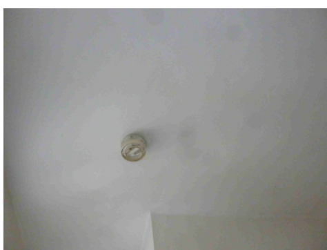
Obr.č.16 Prvky systému umelého osvetlenia
