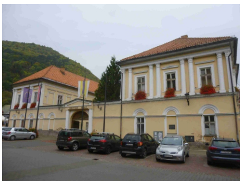
Obr.č.3 Pohľad južný
