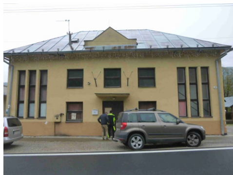
Obr.č.2 Pohľad západný
