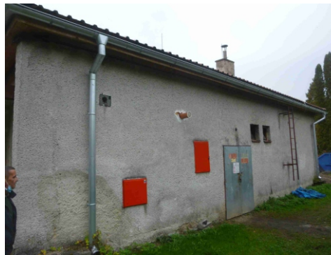
Obr.č.4 Pohľad severný
