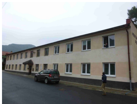
Obr.č.2 Pohľad západný
