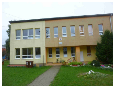
Obr.č.4 Pohľad severný
