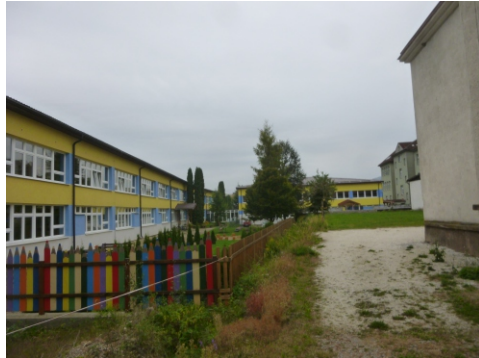
Obr.č.2 Pohľad západný
